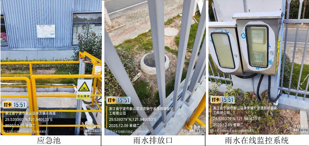
图 4.2-1 环境风险防范措施照片
